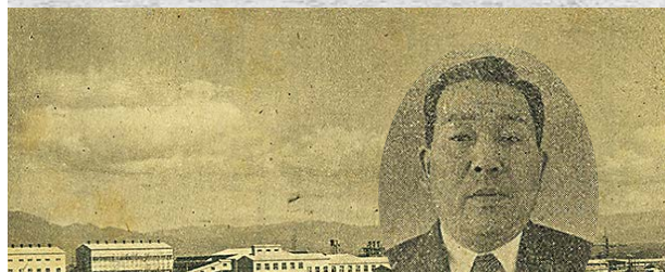
Imagen de la Fundición y refinería de Akita en el momento de su puesta en servicio (en el círculo superior se muestra al Sr. Nakayama, el primer director de la Fundición y refinería de Akita).
